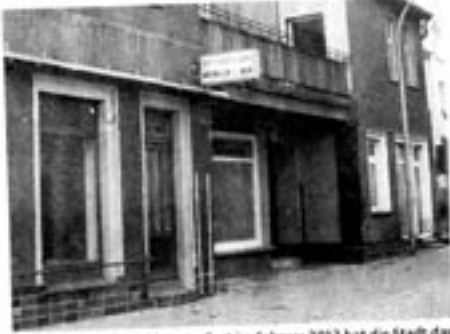
Bis zum Abriss der Schloßstraße 4 im Februar 2012 hat die Stadt das Haus als Kunststevier freigegeben.
